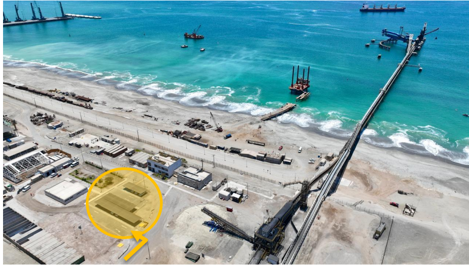
Estacionamientos frente al edificio Administrativo
